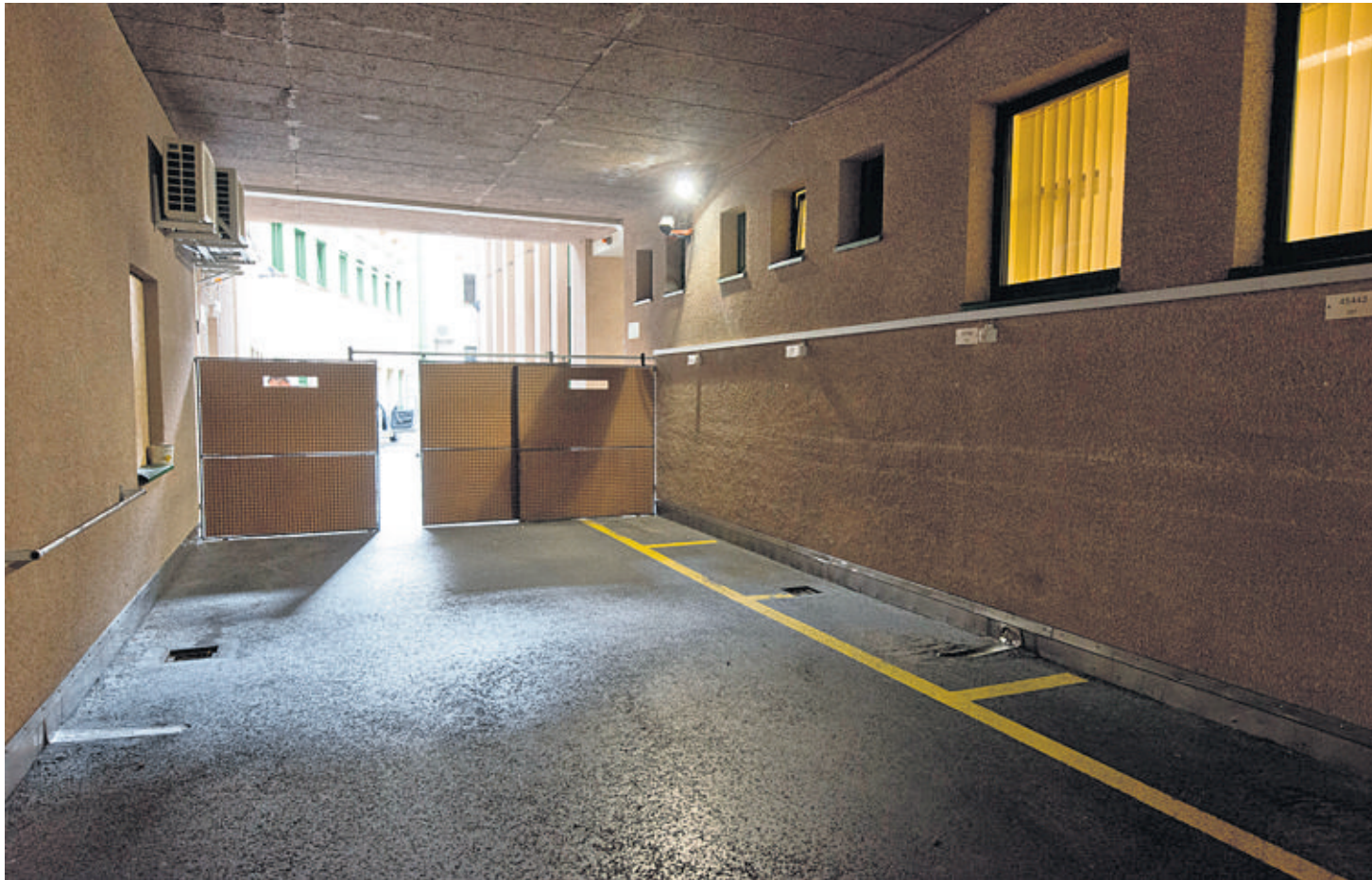
La cour intérieure de l'hôtel de police de Lausanne, aménagée en lieu de promenade pour les prévenus en détention. F. CELLA
